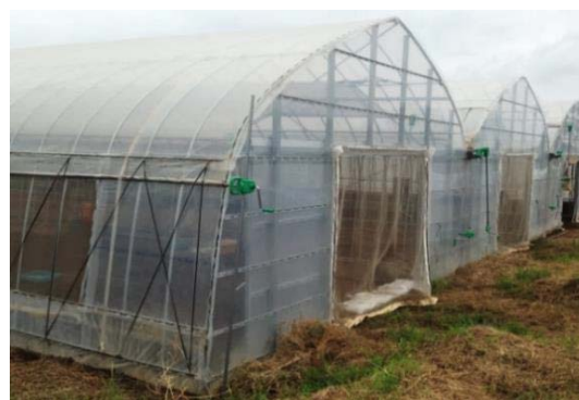
写真5：作業場のビニールハウス
