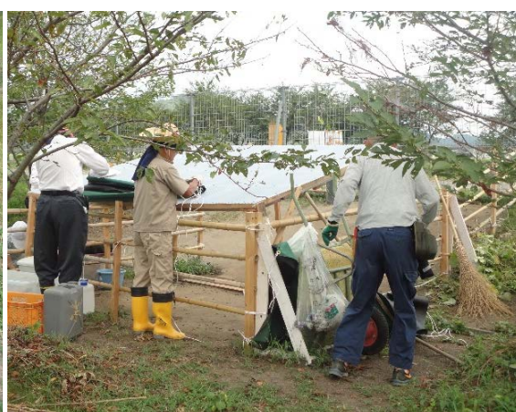
写真5：宿舎を解体する様子
