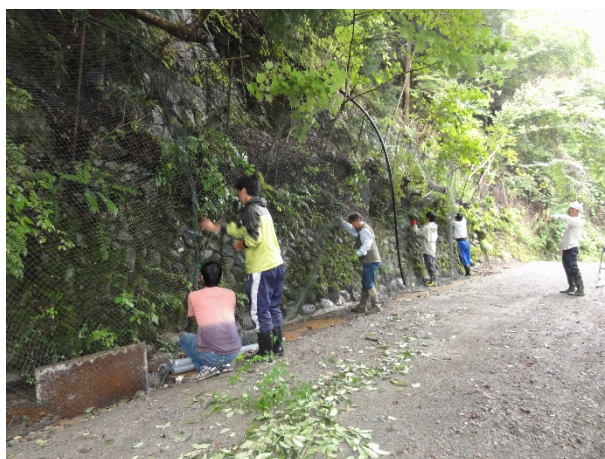
写真11 落石・土砂防止のネット張り作業
