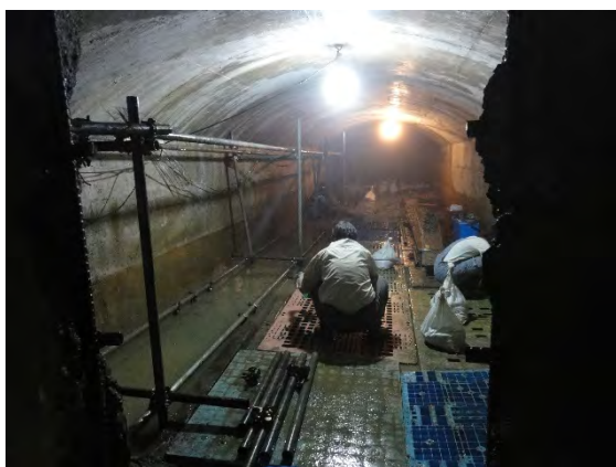
写真8 冠水するトンネル内での足場づくり
