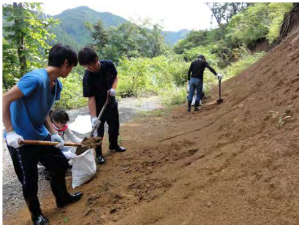
写真6 周辺の山土を利用しトンネルで使用する土嚢を作る
