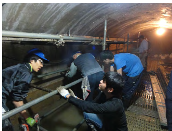
写真9 保存産品を陳列する棚の設置作業
