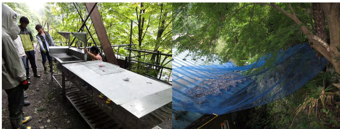
写真 12 トンネル入り口に引きこんだ水を利用 使用した加工設備の設置
