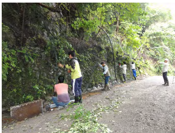
写真11 落石・土砂防止のネット張り作業
