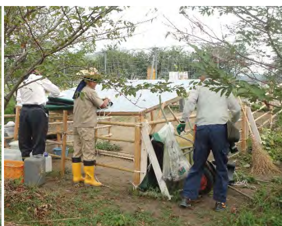
写真5：宿舎を解体する様子
